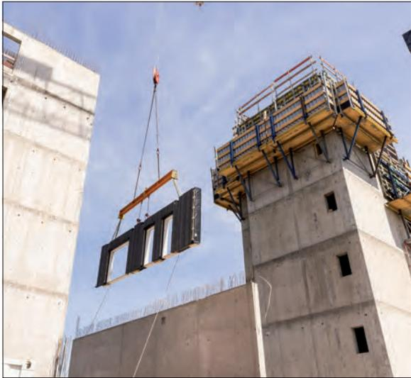
Holzkonstruktion mit einem Treppen Kern aus Stahlbeton – auch auf solche Bauten muss die Musterholzbaurichtlinie angewendet werden (Foto: Garbe Immobilien-Projekte)
